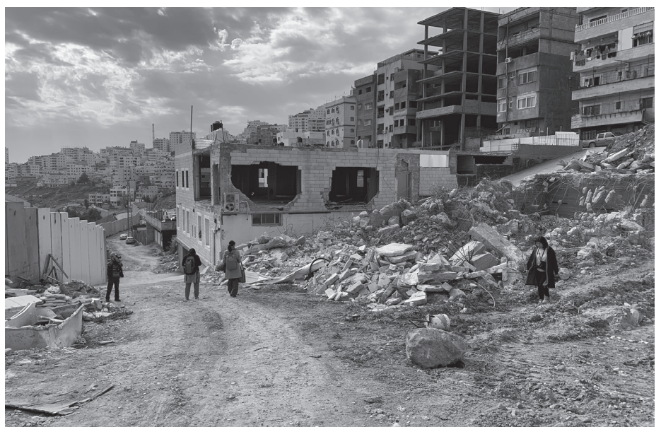
⑥ -a 手前は全壊した民家。奥が、半壊したプール施設。
