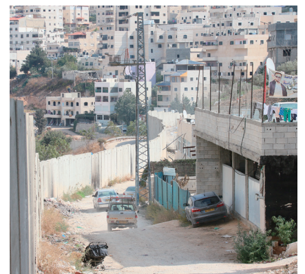
分離壁に隣接した所にある破壊されたプールは、建物の残存部分で運営を開始していた。
