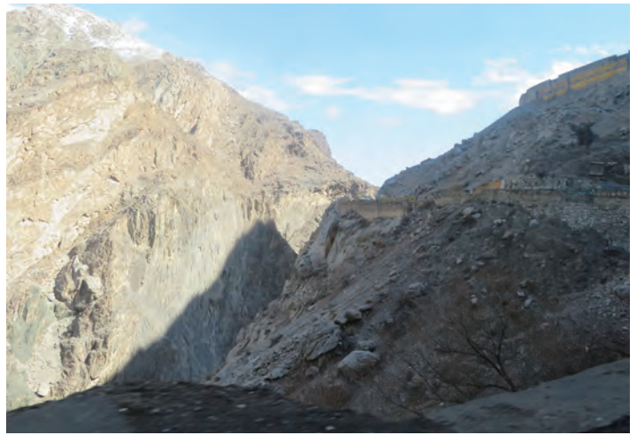
山岳道路の片側は、険しい谷となっている
