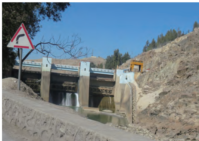
すでにカブール川には3か所のダムが建設されている
