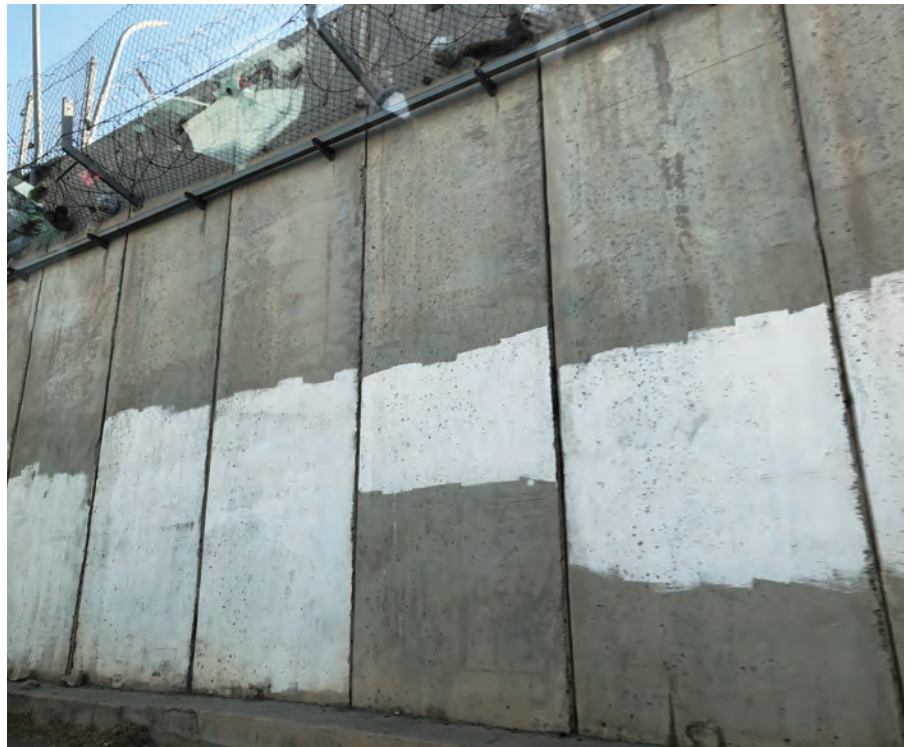
ヨルダン川西岸地区の隔離壁
