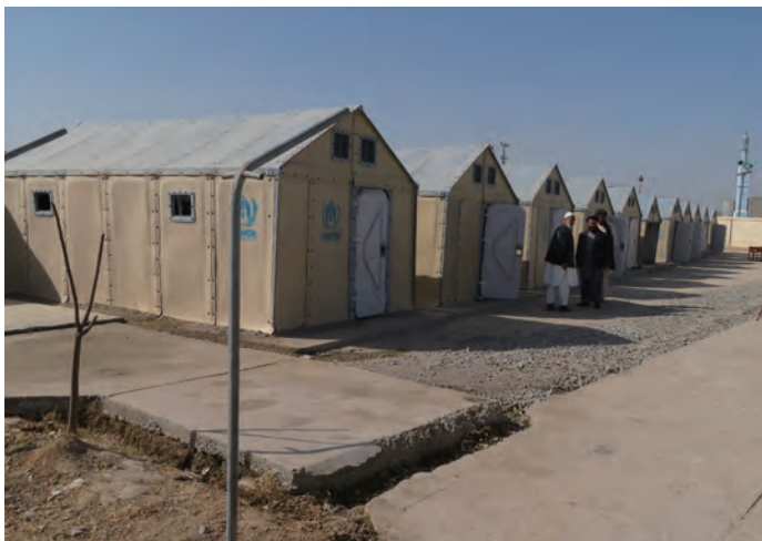
教室が足りず UNHCR のプレハブ小屋が教室として使用
