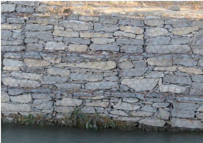
用水路建設に使用される、護岸力の強い蛇籠
